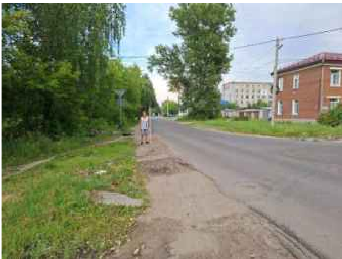
Рис. 287. Археологическая разведка в г. Богородске Богородского района Нижегородской области в 2025 г. Общий вид на маршрут капитального ремонта сетей водоотведения в районе перекрестка ул. Чернышевского и ул. Пушкина. Вид с юго-запада.
